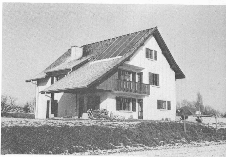
Fig. 1. — Façades sud-est et sud-ouest.
