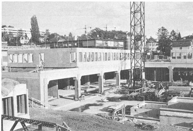
Fig. 8. et 9. — Pose des façades en éléments préfabriqués.
