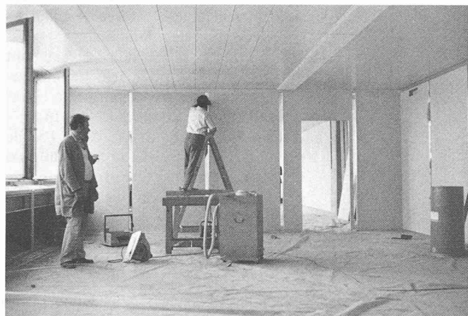
Fig. 10. — Montage des cloisons mobiles.
