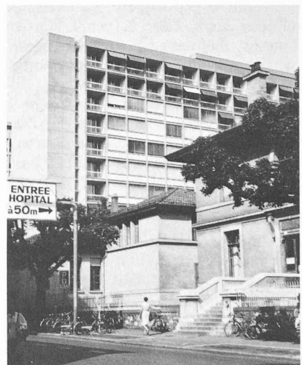
Fig. 1. — Vue partielle de l'Hôpital cantonal de Genève, montrant le contraste entre l'ancien bâtiment et le nouveau.
