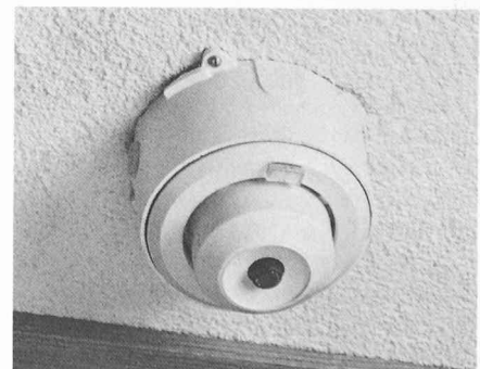
Fig. 9. — Montage du même détecteur à ras du sol, pour la détection de gaz lourds (propane, etc.).
