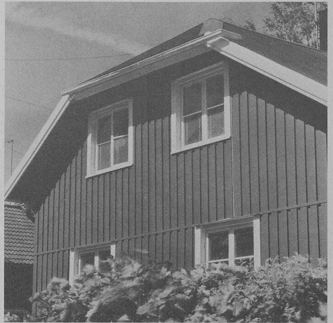
Fig. 2. — Profil, grain et couleur du bardage revêtu de film «Tedlar» PVF s'assortissent bien avec les pans traditionnels suédois, mais le matériel Du Pont ne nécessite aucun entretien.
