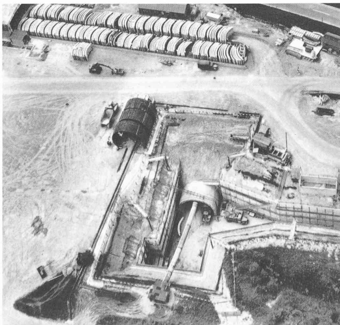
Fig. 7. — Lot ouest. Point d'attaque médian. Le creusement en direction de la gare est en cours. En haut, l'entrepôt des voussoirs.
