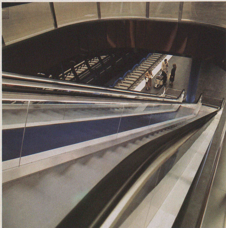
Fig. 2. — Escaliers roulants entre le quai et la halle de la gare.
