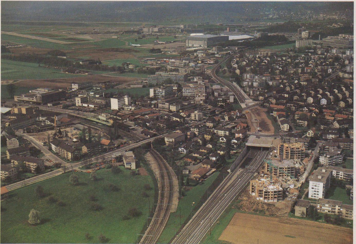
Le chemin de fer arrive à l'aéroport de Zurich. Au premier plan, à droite, bifurcation de l'ancienne ligne passant par la localité de Kloten et de la nouvelle ligne, qui s'engage dans le tunnel de la gare aéroportuaire.
