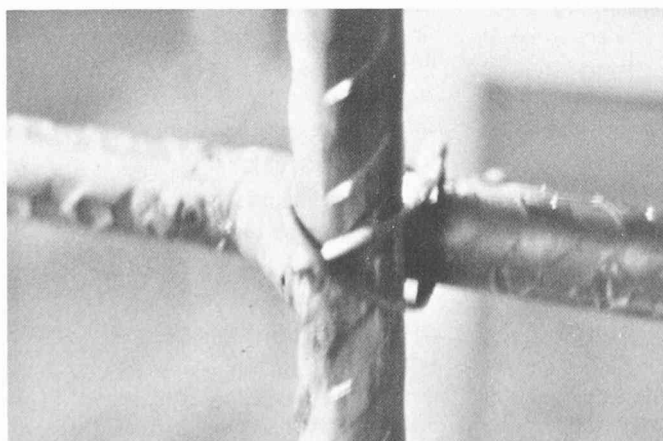
Fig. 12. — Liaison d'armatures par soudure.
