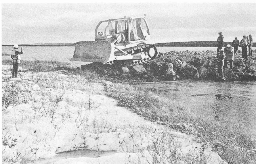
Fig. 21. — Construction du barrage de la Caniapiscau.
