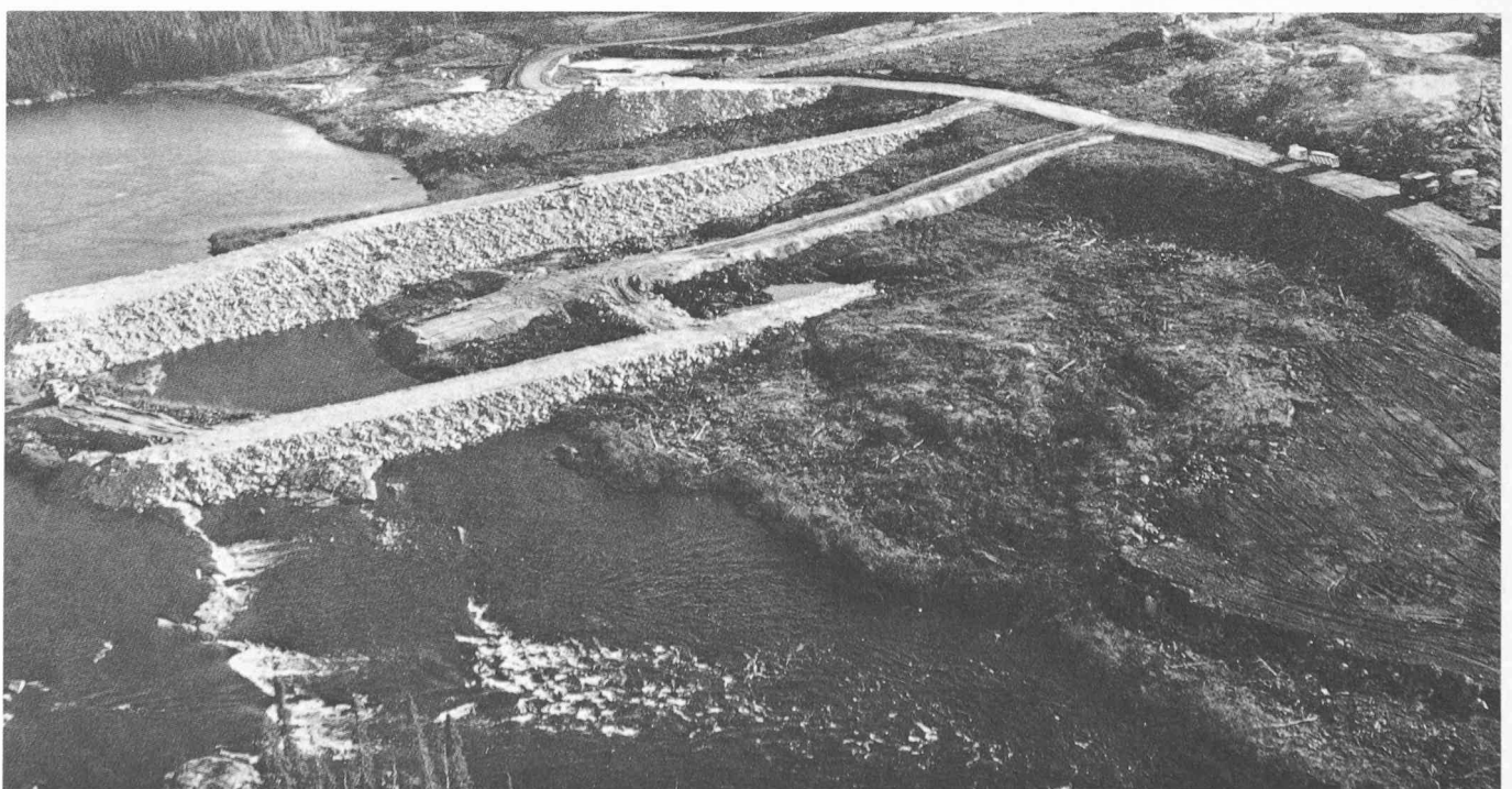
Fig. 19. — Vue des batardeaux amont et aval de la rivière Opinaca ; à l'arrière-plan, on distingue l'évacuateur des crues.
