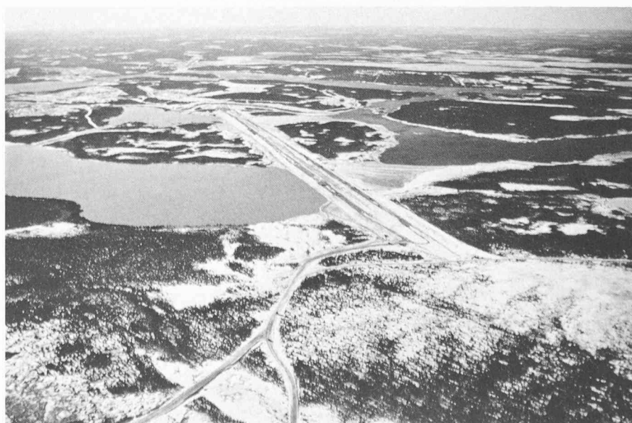
Fig. 22. — Photo du barrage en voie d'achèvement.
