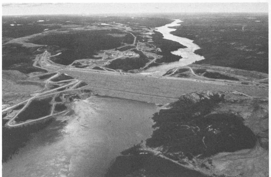
Fig. 9. — Vue du barrage L.G.2. On distingue le couronnement du barrage à 160 m en dessus de la rivière.
