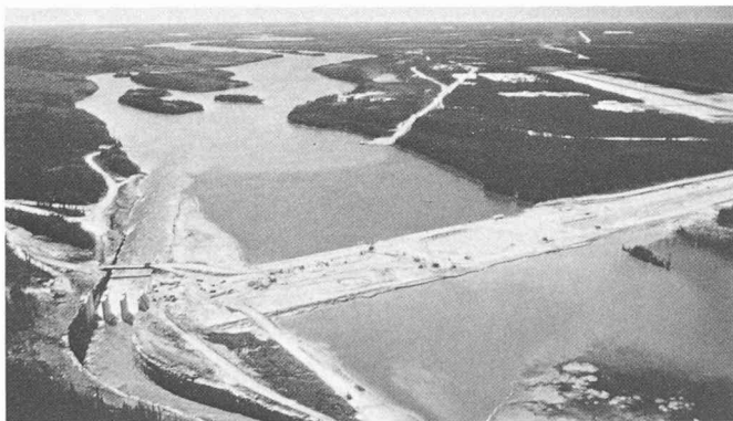
Fig. 15. — Photo durant les travaux du barrage de l'Eastmain. On distingue, à gauche, l'évacuateur des crues.
