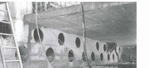
Fig. 2: Le plus grand puit canadien de Suisse est constitué d'un ensemble de tuyaux enterrés horizontalement dans les fondations du parking souterrain (Photo ERTE).
