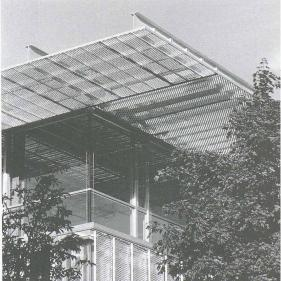
Aux angles Nord-Est et Nord-Ouest du bâtiment, la façade se plie sans être interrompue visuellement par la structure verticale, comme, par exemple, dans la salle de gymnastique (fig. 28).
