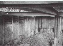
Pour le drainage et l'évacuation des eaux et comme couche de séparation élastique, nous avons recouru à Enkadrain CK 20. Cette application nous a en outre permis de bétonner directement sur la paroi berlinoise, puisqu'Enkadrain fait également office de coffrage perdu.»
