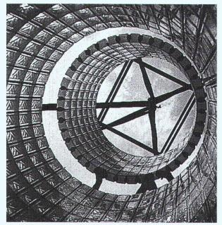
BRIQUES DE VERRE PREFABRICATION MAÇONNAGE SUR CHANTIER
