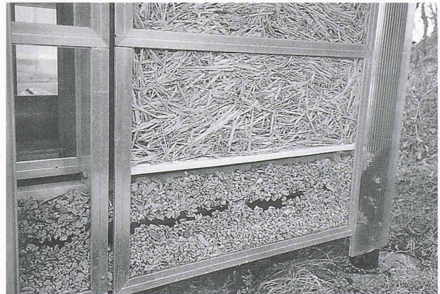
déchets de liège ou la paille hachée. Les colles étant exclues, ces matériaux en vrac doivent être «coulés» entre des parements étanches.
