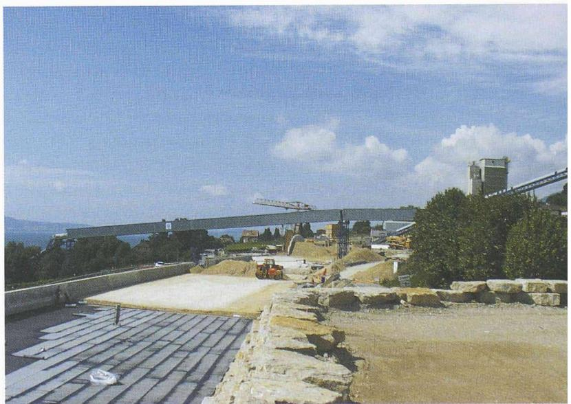
tants volumes nécessaires au dépôt des matériaux à angle de frottement interne plus faible, provenant des chantiers de la Béroche et du tronçon voisin de Treytel-Areuse.
