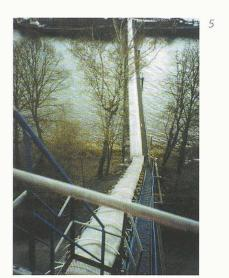
Fig. 3: Portail du tunnel de Sauges, côté St-Aubin, avec galerie technique (GAT) et canal de liaison entre les GAT des deux tubes (en construction) (Photo Jeanneret)
