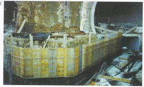
sée, elle est réalisée à l'aide d'éléments préfabriqués posés sur le radier voûté, tandis que le vide de chaque côté est comblé avec des matériaux d'excavation stabilisés au ciment (fig. 3).
