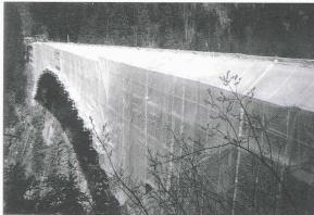
la circulation a été interrompue pour une courte durée. Un échafaudage spécial a été dressé pour remplacer les parapets et effectuer les travaux de béton projeté sur l'arc. L'emballage de l'ouvrage durant une période de six mois lui a même temporairement donné un air d'œuvre conçue par Christo (fig. 5). Enfin, le coût de la restauration s'est élevé à 2,1 millions de francs, dont 300 000 pour les seuls échafaudages.
