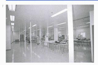
Fig. 1: Vue générale d'une salle blanche. Les parois et le plafond sont réalisés en tôle thermolaquée, le sol en époxy avec remontées arrondies. On notera l'intégration des luminaires et des grilles de soufflage dans les plafonds. Les poteaux verticaux fournissent l'ensemble des alimentations aux postes de travail, ce qui évite les percements dans les parois.
