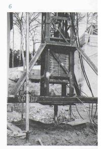
Fig. 8: Principe de remplacement d'un tirant
