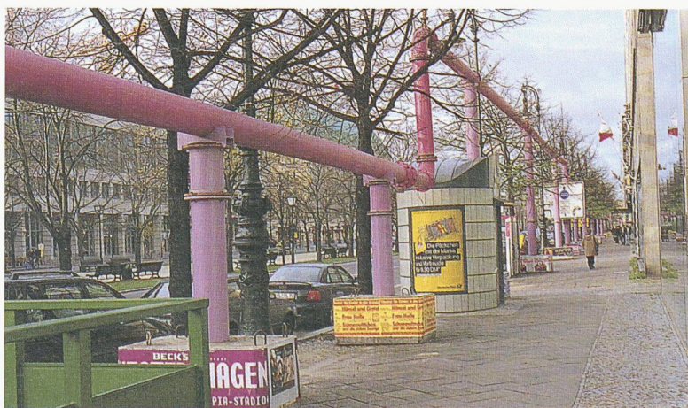
Fig. 3.- Pendant la durée du chantier, le réseau de conduites fait partie de l'image d'une partie de la ville de Berlin (photo IAS)
