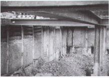
Pour le drainage et l'évacuation des eaux et comme couche de séparation élastique, nous avons recouru à Enkadrain CK 20. Cette application nous a en outre permis de bétonner directement sur la paroi berlinoise, puisqu'Enkadrain fait également office de coffrage perdu.»
