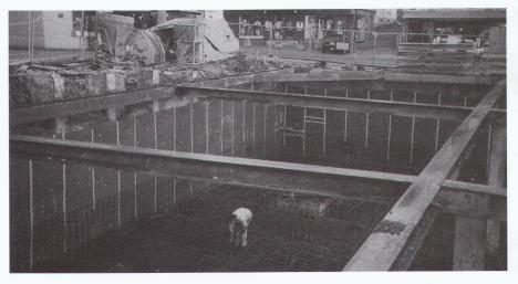
de ces pieux a en outre été muni de tubes d'acier, dans lesquels passeront des tuyaux synthétiques destinés à l'extraction de la chaleur terrestre (géothermie). Les murs de fondation ont également été équipés de tuyaux, réunis dans un puits affecté à cette application énergétique.
