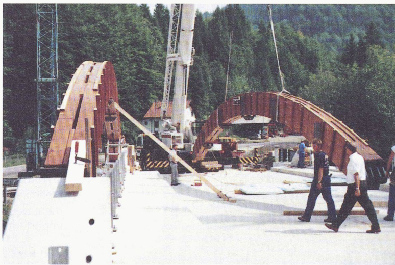
Fig. 6. – Montage des arcs à l'aide d'un camion-grue
