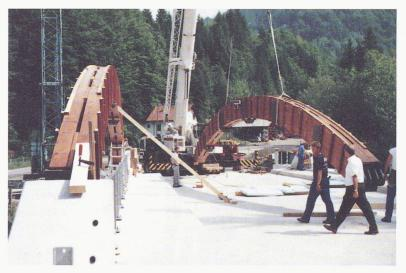
Fig. 6.- Montage des arcs à l'aide d'un camion-grue
