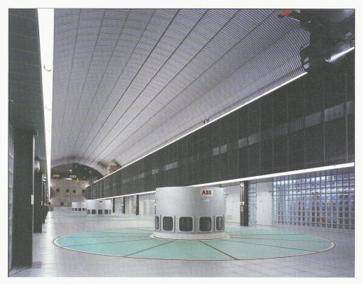
Fig. 3. - Partie visible de la caverne, comprenant les couvercles des alternateurs (Photo H. Preisig, Sion)
