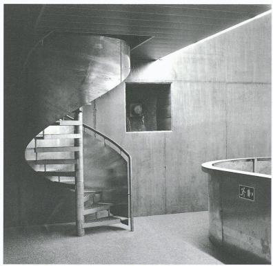
Fig. 5. - Eléments d'escaliers et garde-corps en acier zingué au feu (Photo Yves Eigenmann, Fribourg)
