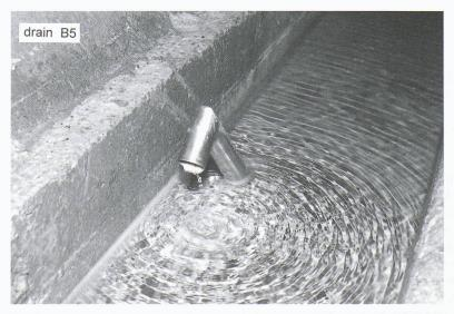
Fig. 4. - Vue de quelques drains à l'intérieur du barrage du Naret 1. Sur les drains B4 et B5, mis en service en 1990, on note déjà un dépôt de carbonate.
