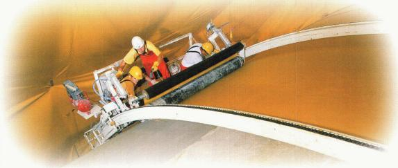
Intre Payerne et Yverdon se construit actuellement le dernier tronçon de la route nationale Al. Lors des travaux d'étanchéité réalisés sur cet ouvrage de 540 m de long de la «Tranchée couverte de Sévaz», percé sous la ligne ferroviaire, l'entreprise SikaBau Zurich et son partenaire\* ont dû maîtriser deux problèmes:
