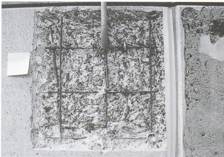
Fig. 1. Zones de mesure «re-profilées», avant le re-profilage
