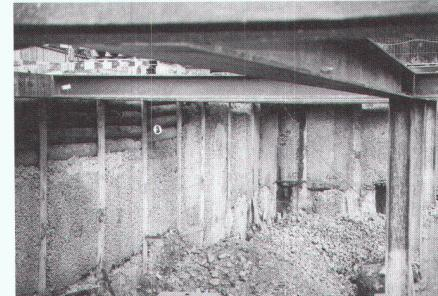
Pour le drainage et l'évacuation des eaux et comme couche de séparation élastique, nous avons recouru à Enkadrain CK 20. Cette application nous a en outre permis de bétonner directement sur la paroi berlinoise, puisqu'Enkadrain fait également office de coffrage perdu.
