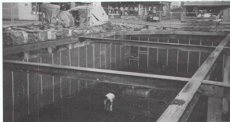
de ces pieux a en outre été muni de tubes d'acier, dans lesquels passeront des tuyaux synthétiques destinés à l'extraction de la chaleur terrestre (géothermie). Les murs de fondation ont également été équipés de tuyaux, réunis dans un puits affecté à cette application énergétique.
