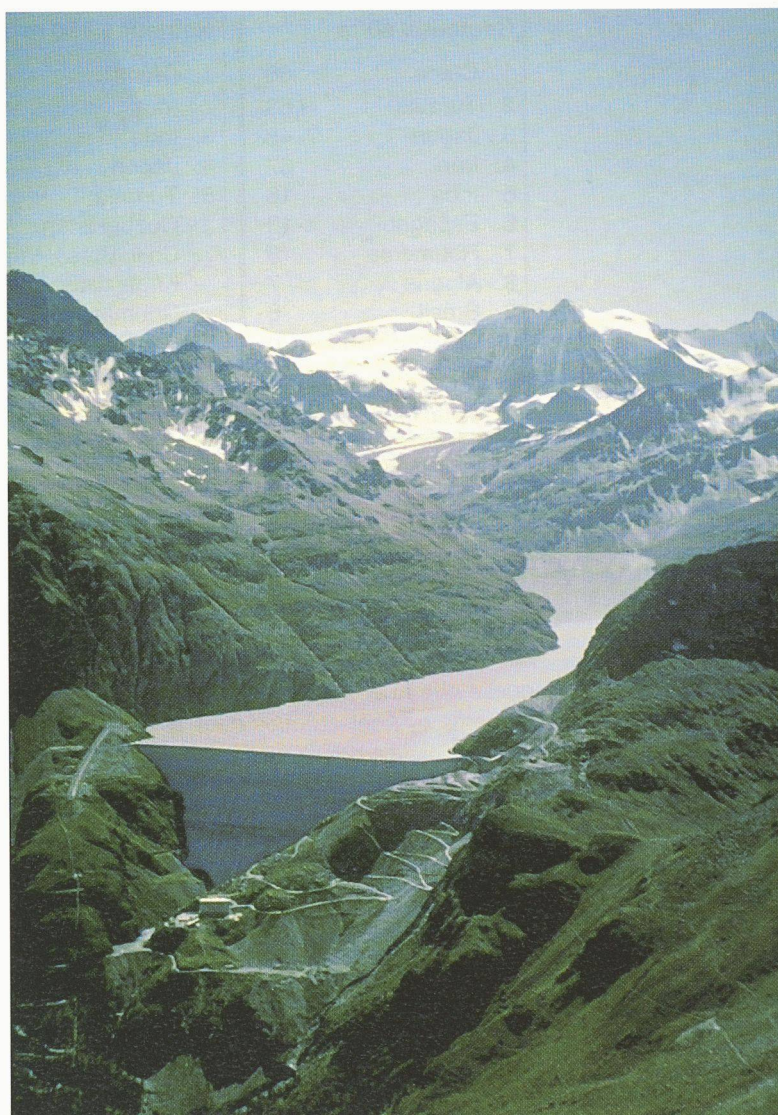
Fig. 5. – Barrage de la Grande-Dixence (285 m)
