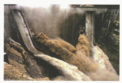
Fig. 10.— Barrage de Jiroft en Iran lors d'une crue d'environ 5000 m³/s (photo : Stucky Ingénieurs-Conseils SA)
