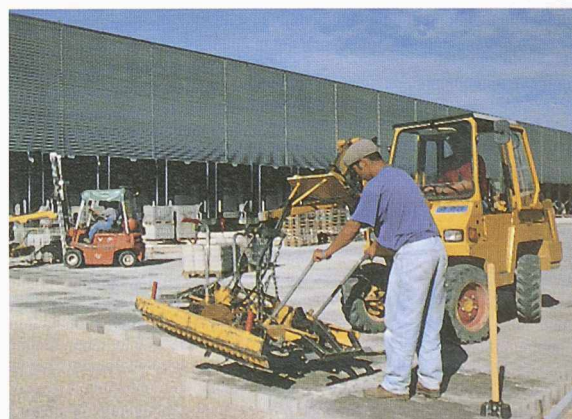
Pose mécanisée: le véhicule (à droite) apporte un ensemble de pavés disposés en carré, qu'il dépose en l'imbriquant avec les pavés déjà posés. L'alignement s'effectue manuellement sans difficultés. (Photo BTR)
