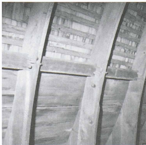
Fig. 4.- a) Liaison cerces-liernes proposée dans l'ouvrage de 1567 (à gauche) b) Liaison cerces-liernes réalisée à la Blécherette (à droite)
