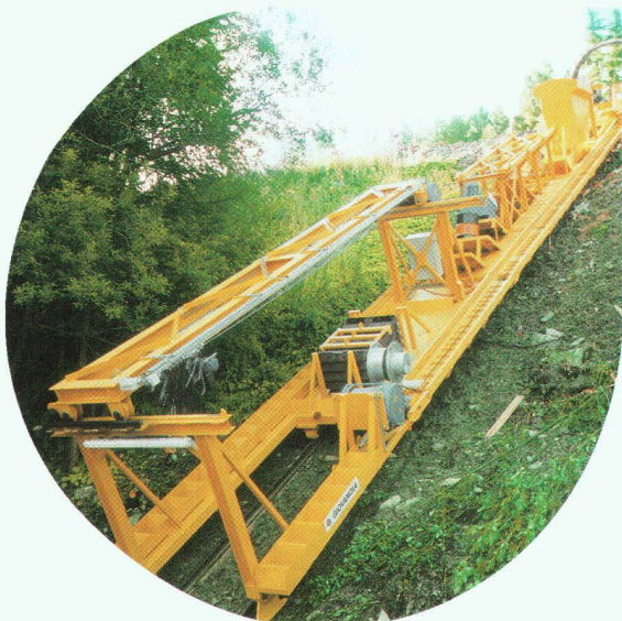
Cleuson-Dixence, Back-up pour tunnelier LOVAT
