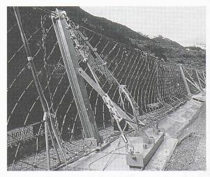
Fig. 3.- Filets de protection contre les chutes de pierres soutenus par des mâts à genouillère sur le couronnement des murs de soutènement
