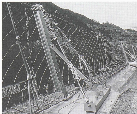
Fig. 3.- Filets de protection contre les chutes de pierres soutenus par des mâts à genouillère sur le couronnement des murs de soutènement
