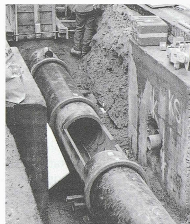
Fig. 2.- Conduite en grès posée sous la bande médiane avec découpe pour la rigole traversante du regard de visite. De chaque côté, on distingue les piédroits nécessaires au fonçage sous pression.
