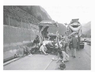
ig. 3.- Mise en place du béton sur la bande médiane à l'aide d'une isphalteuse modifiée (progression journalière : 150 m environ)
