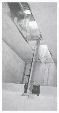
Fig. 5.- Détail du séparateur d'huiles minérales type K avec escalier à grenouilles et échelle d'accès au bassin de rétention des boues
