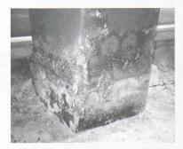
Fig. 5.- Etat du pied d'une colonne centrale avant la remise en état
