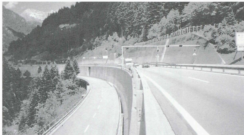
Fig. 13.- Murs et parois de soutènement, vue générale
