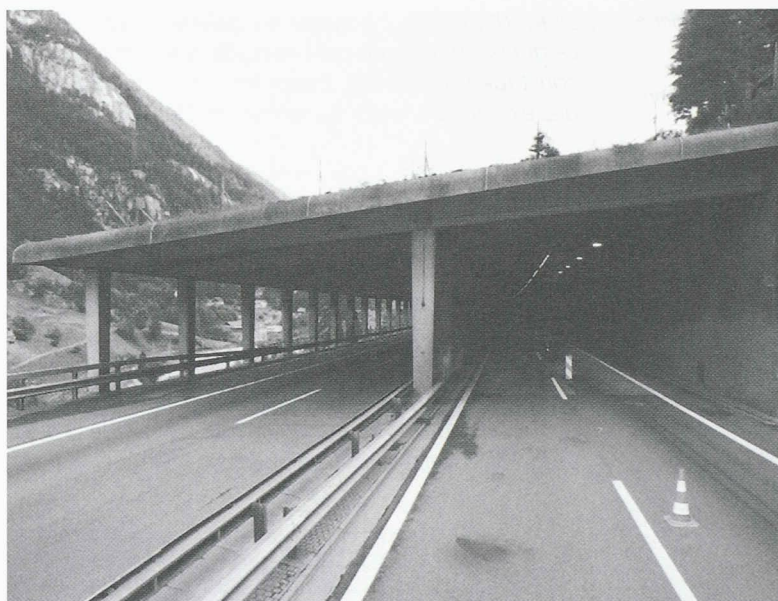
Fig. 3.- Galerie paravalanches de Willerplangen, portail Sud
