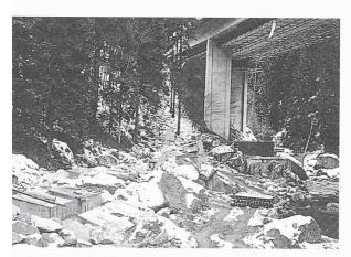
ig. 2.- Prismes de béton dans la zone des piles centrales (RO 5)
