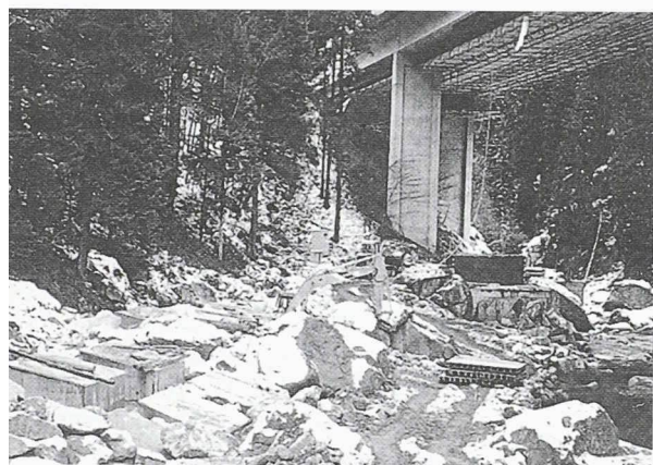
Fig. 2.- Prismes de béton dans la zone des piles centrales (RO 5)
