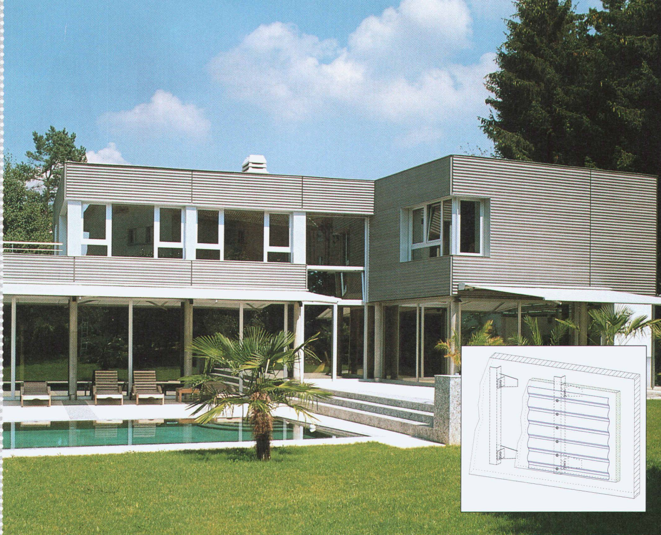
Villa, Lausanne. Architecte : Roland Mosimann, 1009 Pully. Fournisseur des profils : Forges Profil S.A., 5416 Kirchdorf. Construction de la façade : Ray S.A., 1762 Givisiez
