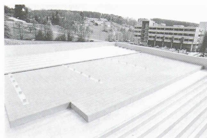
Le panneau isolant EUROTHERM pour EUROTOIT. Sa masse volumique plus faible facilite le montage et contribue à alléger l'ensemble de la construction.
