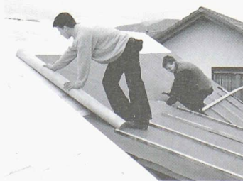
La nouvelle feuille de protection du voligeage, ouverte à la diffusion, Delta-Foxx, est particulièrement facile à poser.
