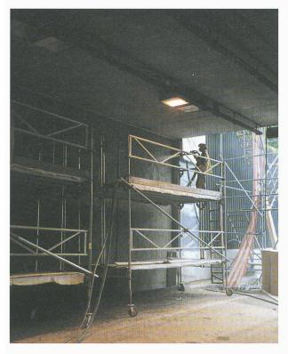
Fig. 6.- Enrobage du treillis par béton projeté
