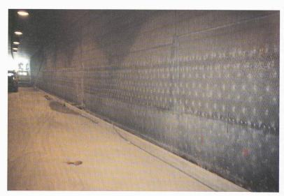
Fig. 3.- Treillis avant bétonnage
