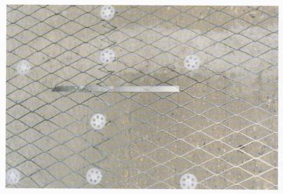
Fig. 4.- Détail treillis en titane
