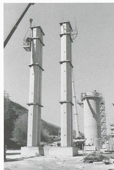
Fig. 9.- Pile provisoire en béton centrifugé
