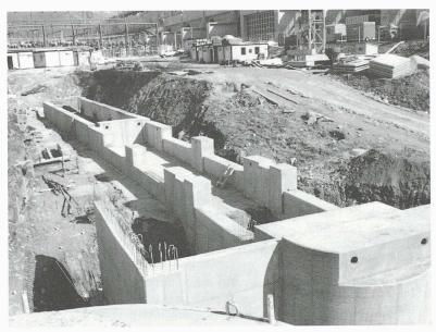
Fig. 4. – Culée Viège liée au banc de poussage et de fabrication
