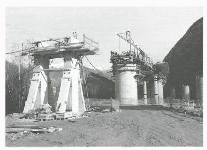
Fig. 2 - Pile provisoire en bois rive droite
