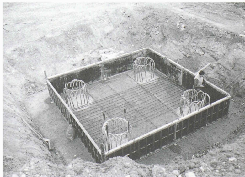
Fig. 3. – Fondation sur pieux rive gauche
