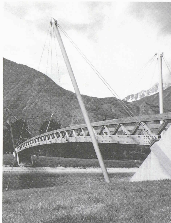
La Suisse bénéficie d'une riche tradition dans la construction de ponts. De nos jours, on utilise de nouveau le bois pour réaliser des ponts modernes. Exemple convaincant, tant techniquement qu'esthétiquement: la passerelle du restoroute de Martigny.
