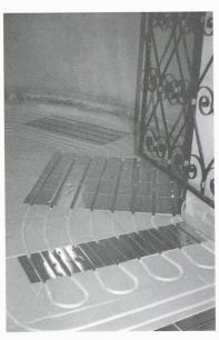
Metalplast Compact-plus: la construction modulaire de ce système de chauffage par le sol s'adapte aux géométries les plus spéciales.
