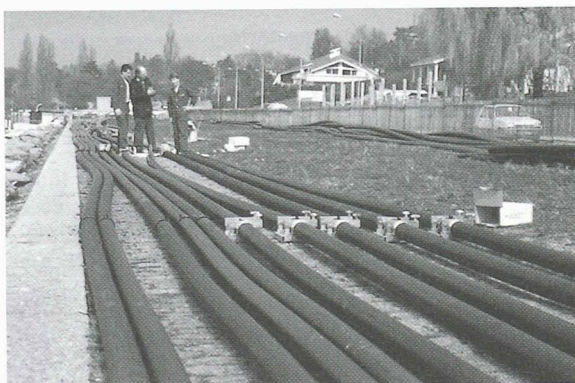
Pose de tubes sur un chantier (Genève)
