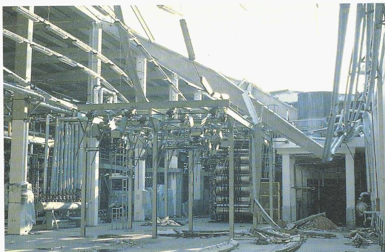
Fig. 7.- Portion effondrée du toit d'une usine, entraînant la destruction complète d'une chaîne de teinture de textile
