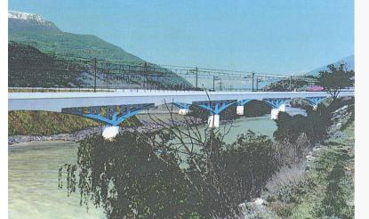
précontraint réalisé en encorbellement sur treillis 335 métallique, à partir d'un pont de service provisoire,
