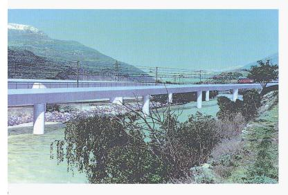
zoïdal de 3,50 m de hauteur, réalisé sur un cintre mobile portant par-dessous;
