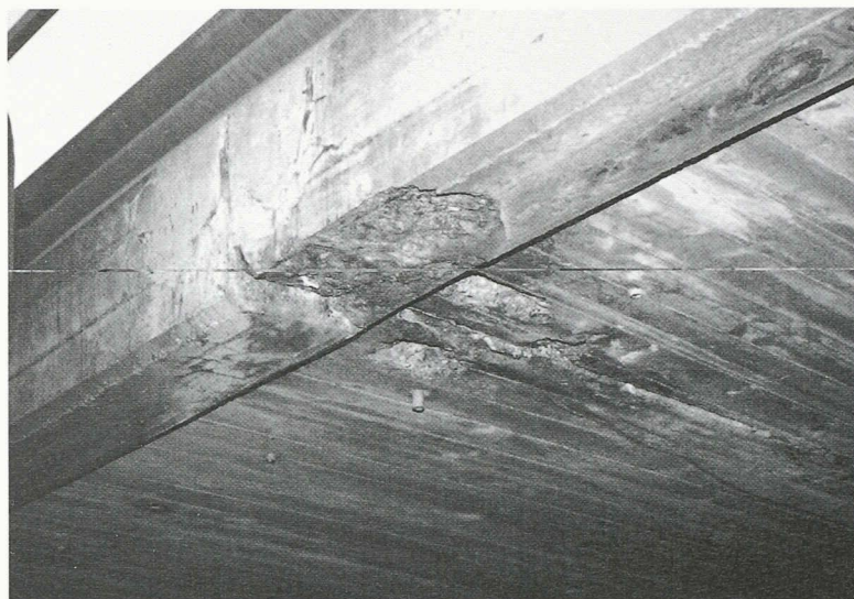
Fig. 6. – Dégénération du béton sur les bordures de l'ouvrage
