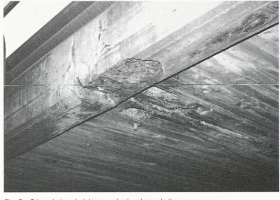
Fig. 6.- Dégradation du béton sur les bordures de l'ouvrage
