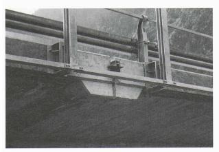
Fig. 11.- Détail après exécution du renfort des bordures (goujons) au droit des joints modifiés
