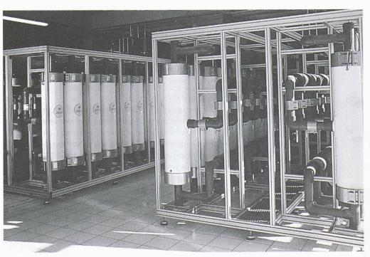
Disposition des blocs comprenant quelques dizaines de modules de filtration chacun à l'usine de l'Apié (F)
