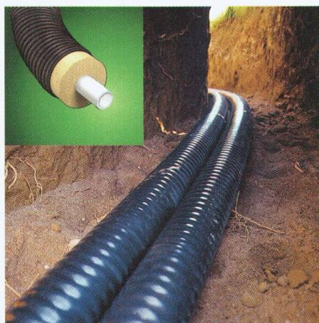
Flexopan-Pex – Le système de tuyaux **flexibles** pour la chaleur à distance, le chauffage et le sanitaire.
