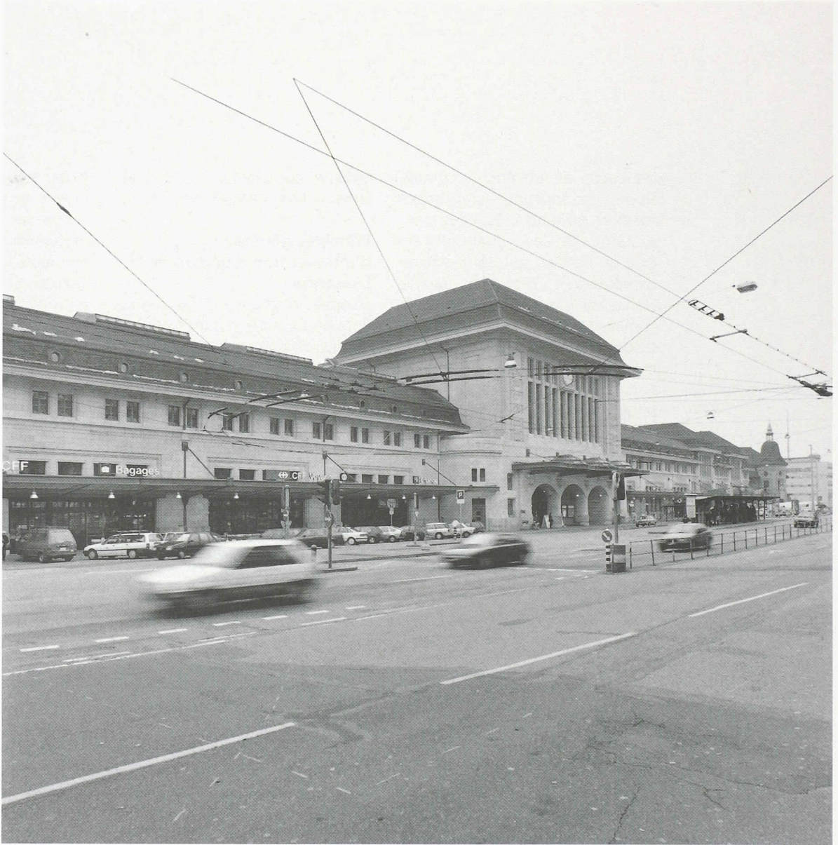
La façade nord restaurée avec le hall principal et les ailes ouest et est.
