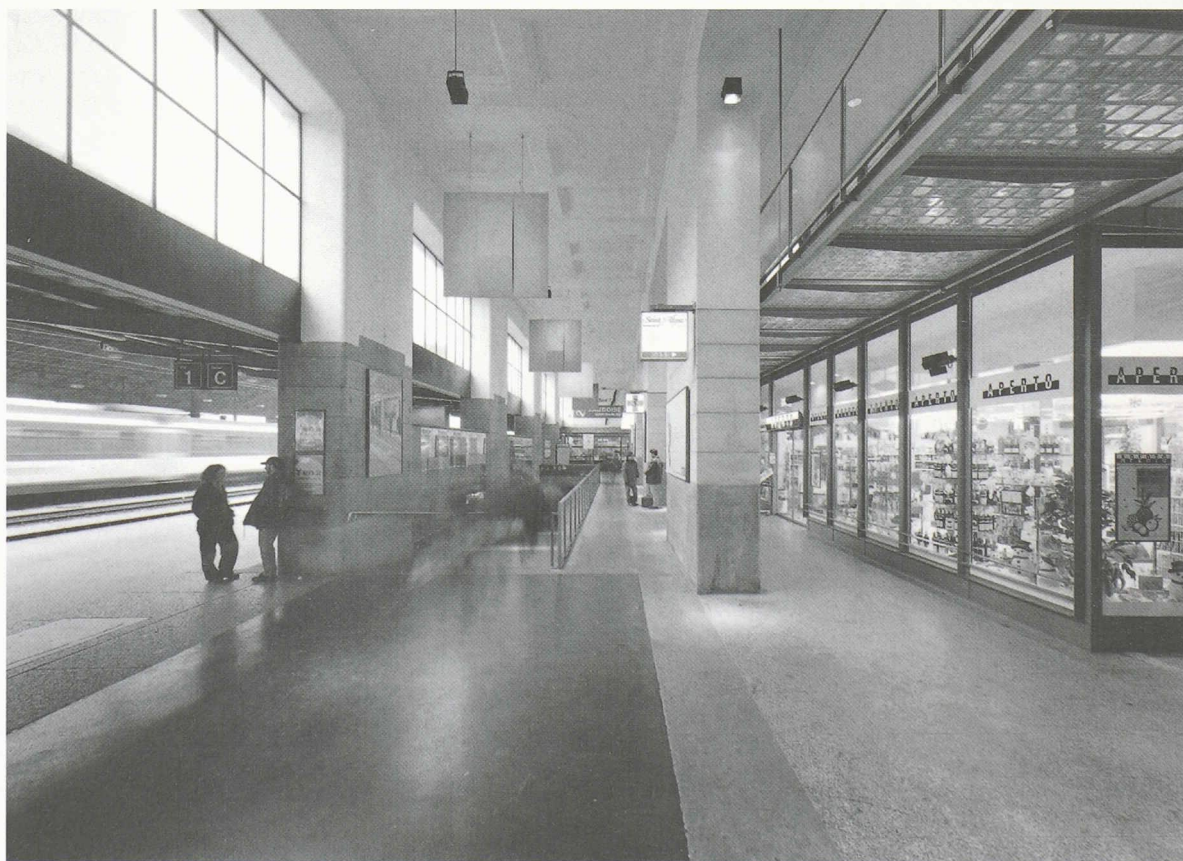
L'aile est avec des magasins sur deux niveaux orientés vers les voies. Passerelles et escaliers transparents. C'est une des interventions les plus lourdes, justifiée par les transformations précédentes qui avaient enlevé à cette partie du bâtiment toute sa substance historique
